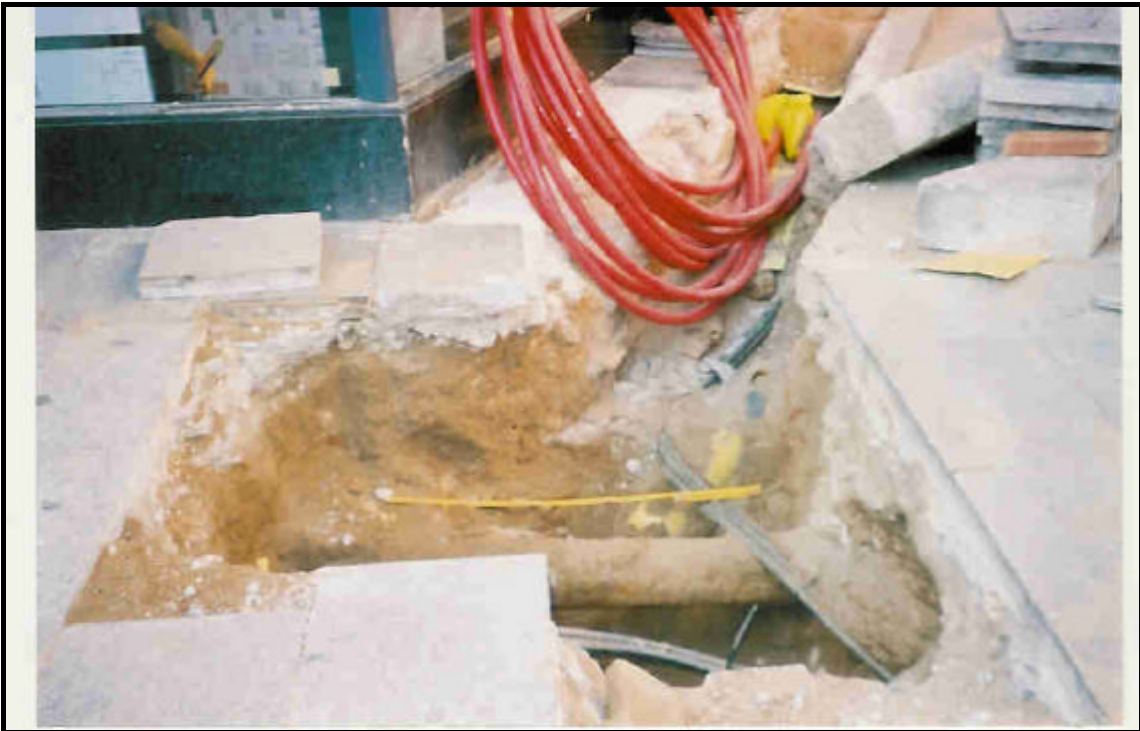
F.9: Extrem sud de la rasa amb una important quantitat de serveis.
