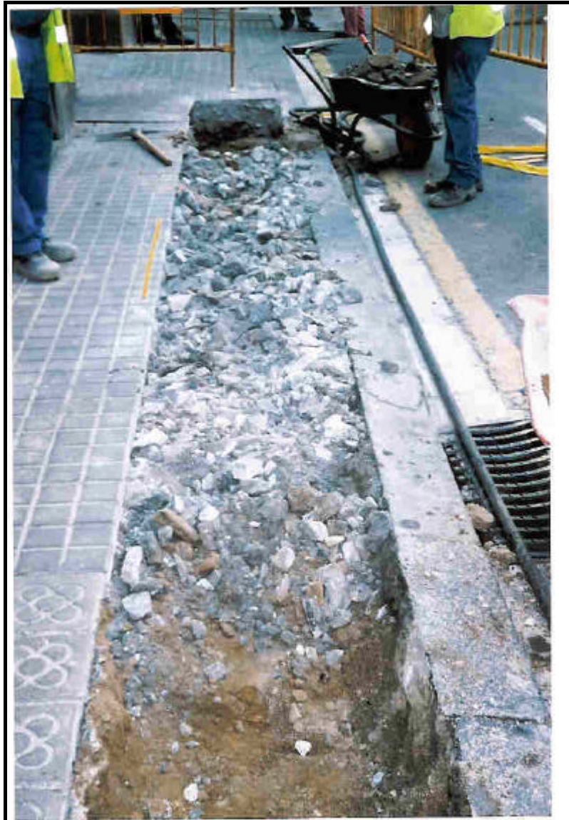
F. 3: Estrat que correspon a la preparació del paviment. U. E: 101, de 10 cms de potència).
