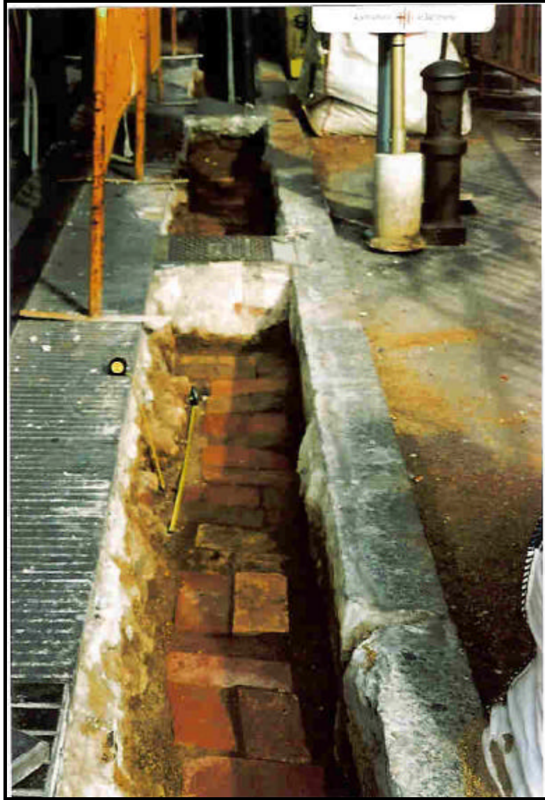
F. 5: Solera de totxos d'un servei elèctric.
